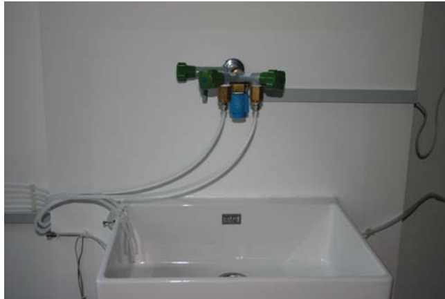
Abbildung 32: Wasserhauptanschluss für die beiden Kühlkreisläufe
